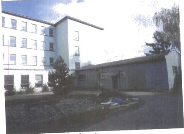
Západný pohľad na objekt s prístavbami laboratórií, dielni a trafostanice
